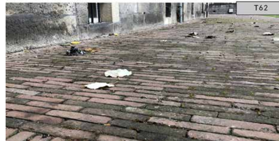
Een klinkerverharding vanaf de dag van behandeling en na 55 dagen. Een éénmalig behandeling geeft een langdurig verbeterde beeldkwaliteit.
